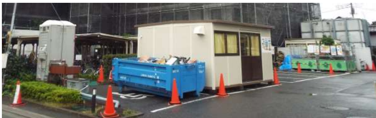
左から 現場手洗い場・修繕廃棄物コンテナ・作業員休憩場・作業出入口通路・ベランダ植栽置場、現場事務所
