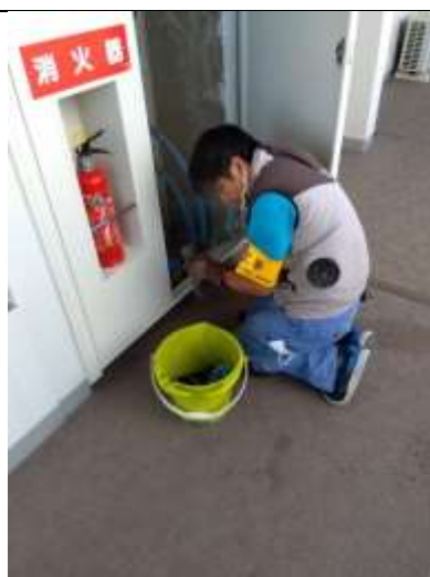
水道メーターの交換作業
