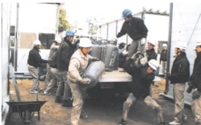
仮設住宅へのLPガス据付作業
