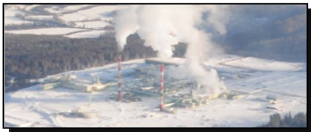
天然ガス処理工場 (二酸化炭素 2,200トン/日排出)
