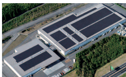
物流施設や店舗の屋などで、再生可能エネルギー設備の導入を行っています。写真はコープネット東金要冷蔵品センター（千葉県東金市）
